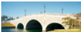
PONCEAU VOUTE BÉON
