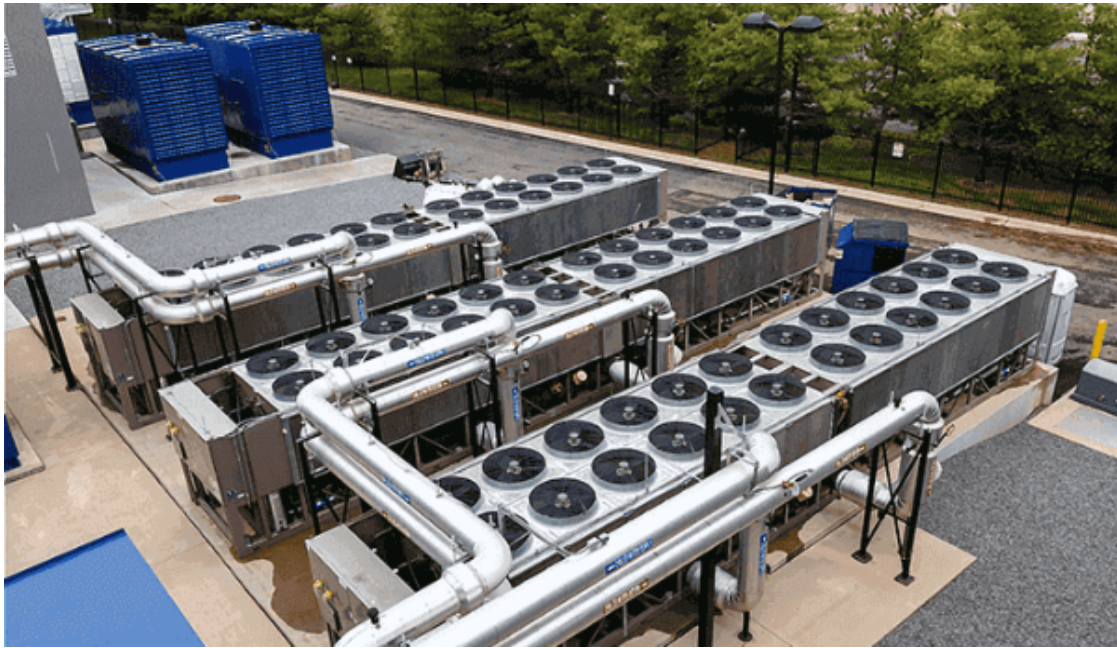
Figure 4. Système de refroidissement par ventilateurs [www.topchiller.com]
