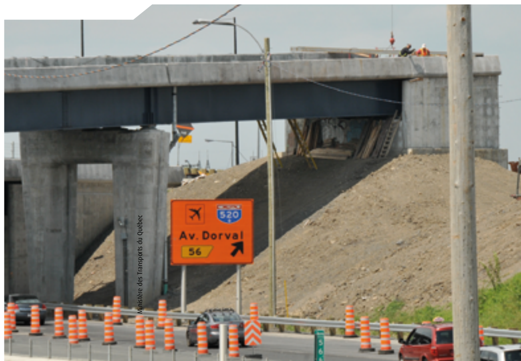
Travaux à l'échangeur Décarie
